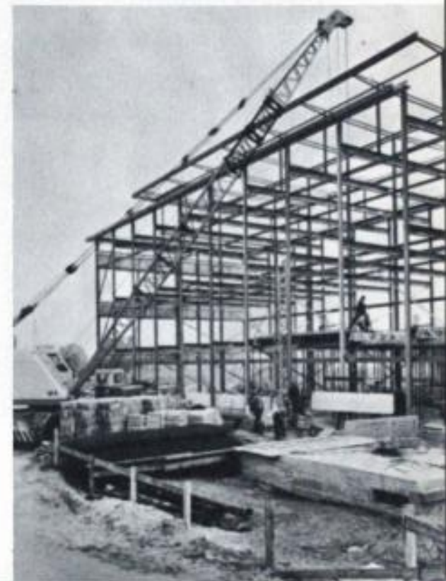
zomer 1965 Gebouw F in opbouw ►
